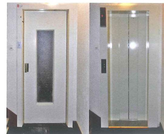
Beispiel einer Modernisierung eines alten Aufzugs mit Schachtdrehtüren in Paris, Frankreich, durch Türen der Serie Fineline der Firma Wittur An example of modernization with Wittur Finline doors of an old lift with swing landing doors in Paris, France.
